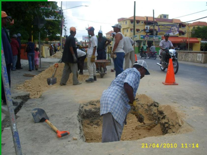
4. Perforación de cuatro (4) pozos filtrantes, para la recolección de las aguas pluviales provenientes de las escorrentías superficiales generadas en las intersecciones formadas por las calles Apocalipsis y Herejía en el Villa Maranata.
